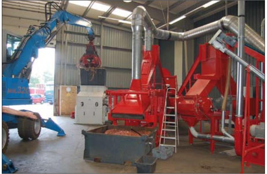
Een speciale Zeno voorshredder is geïnstalleerd, gevolgd door een speciaal gemodificeerde shredder van het Zweedse merk Redoma.
